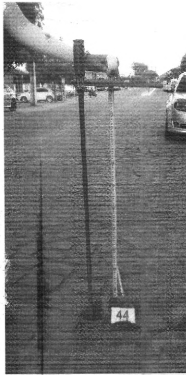
Foto 62 – ST 44 – Solo argiloso sobre rocha pouco alterada. Av. Paulo Bastos, com revestimento asfáltico.
