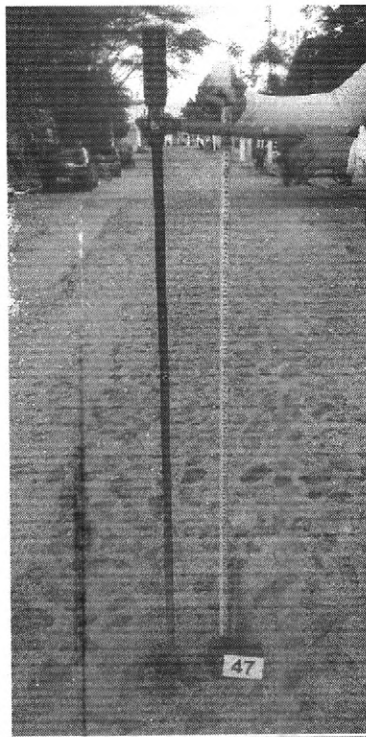
Foto 68 – ST 47 – Solo argiloso sobre rocha pouco alterada. Rua Walmar Braga, com revestimento em pedra tosca.
