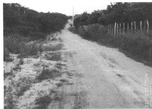
Vista do trecho -3.826069, -39.774993
