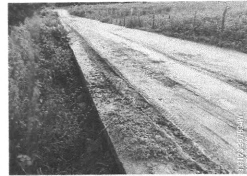
Vista do trecho -3.831181, -39.783416
