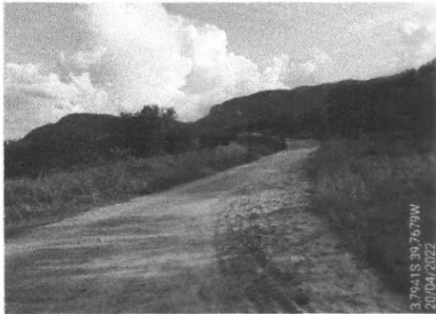
Vista do trecho -3.794135, -39.767904
