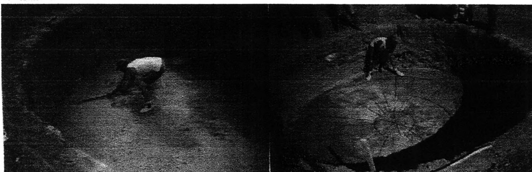
Execução da laje do fundo
