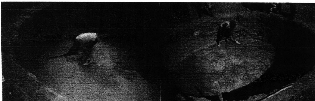
Execução da laje do fundo
