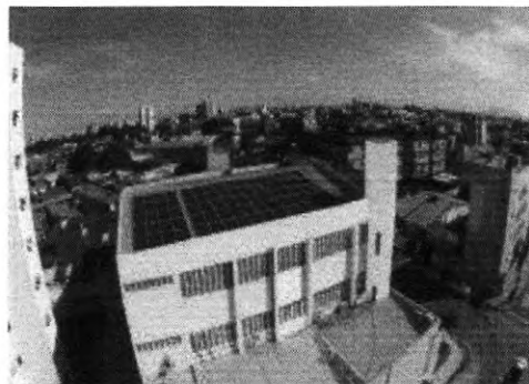
Sistema: 20 kWp Geração: 3.160kWh/mês
