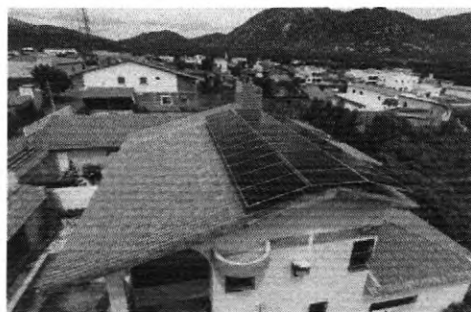
Sistema 12 kWp Geração: 1.900 kWh/mês
