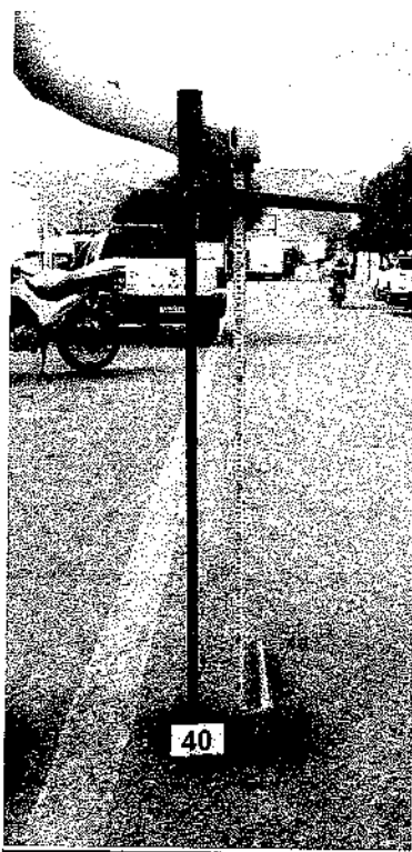
Foto 43 – ST 40 – Solo argiloso sobre rocha alterada. Rua Marlim Dutra, com revestimento asfáltico.
