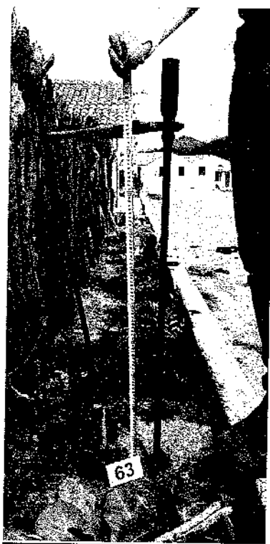
Foto 42 – ST 63 – Solo argiloso sobre rocha pouco alterada e ocorrência de matações. Rua Antônio Euclides Albuquerque, com revestimento em pedra tosca.
