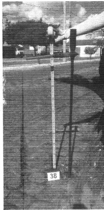
Foto 32 – ST 38 – Solo argiloso sobre rocha alterada. Av. Paulo Bastos, com revestimento em paralelepípedo.
